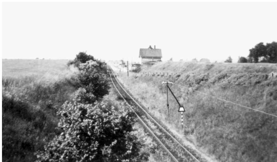
Der Bahnschacht bei Norderstapel mit Blick zum Bahnhof (Foto Archiv der Landschaft Stapelholm)
