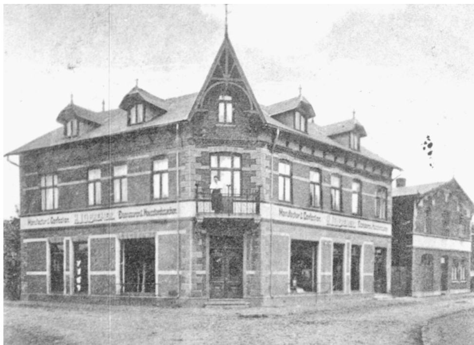
Nach dem Abbruch des alten Kompastorenhauses wurde auf dem Grundstück ein neues Geschäftshaus errichtet. (Foto Sammlung Arno Vorpahl)
